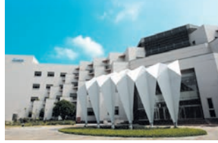
Tainan Fabrika (Elmas Sınıfı Yeşil Bina)
